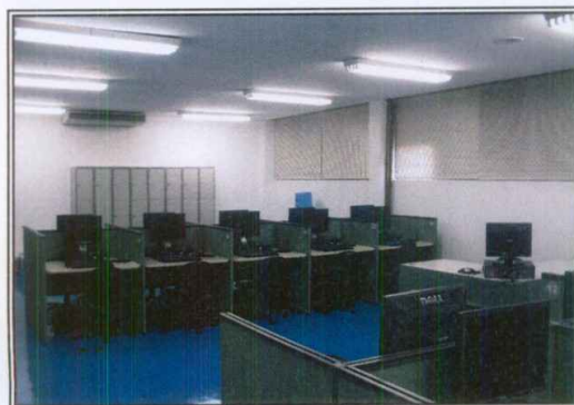
Supervisão/Central de Processamento de Dados
